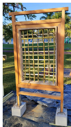
Figura 2 - Módulo de uma parede de pau a pique
