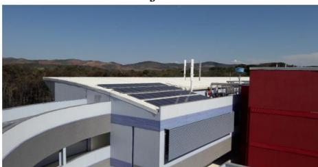
Os painéis instalados conforme apresentado na Figura 1, são divididos em 4 *strings*, cada uma com 10 painéis. As *strings* por sua vez são conectadas em 2 inversores solares, sendo esses da marca ABB e PHB, ambos com potência nominal de 5kW. Tais equipamentos são apresentados na Figura 2.
