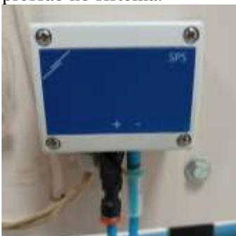
Figura 2 - Sensor de pressão instalado próximo à placa de orifício.
